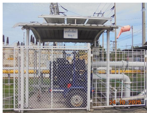
รูปที่ 16 การติดตั้งปั๊มสูบน้ำป้องกันน้ำท่วม
