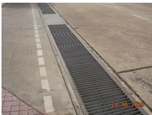
รูปที่ 13 รางระบายน้ำรอบพื้นที่โครงการ
