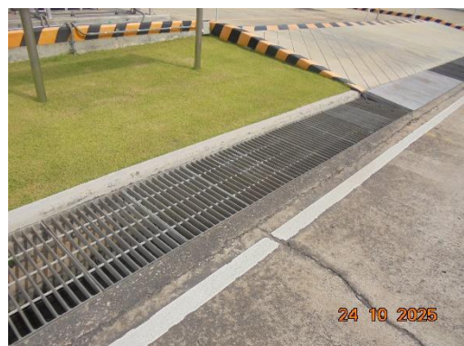
รูปที่ 13 รางระบายน้ำรอบพื้นที่โครงการ
